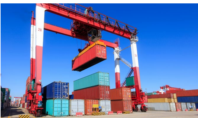
Überwachung kritischer Bauteile bei zentralen Anlagen
